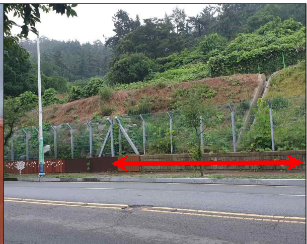
청소년문화공동체 ~ 고향재가복지센터 건너편 주차장 옹벽 구간
